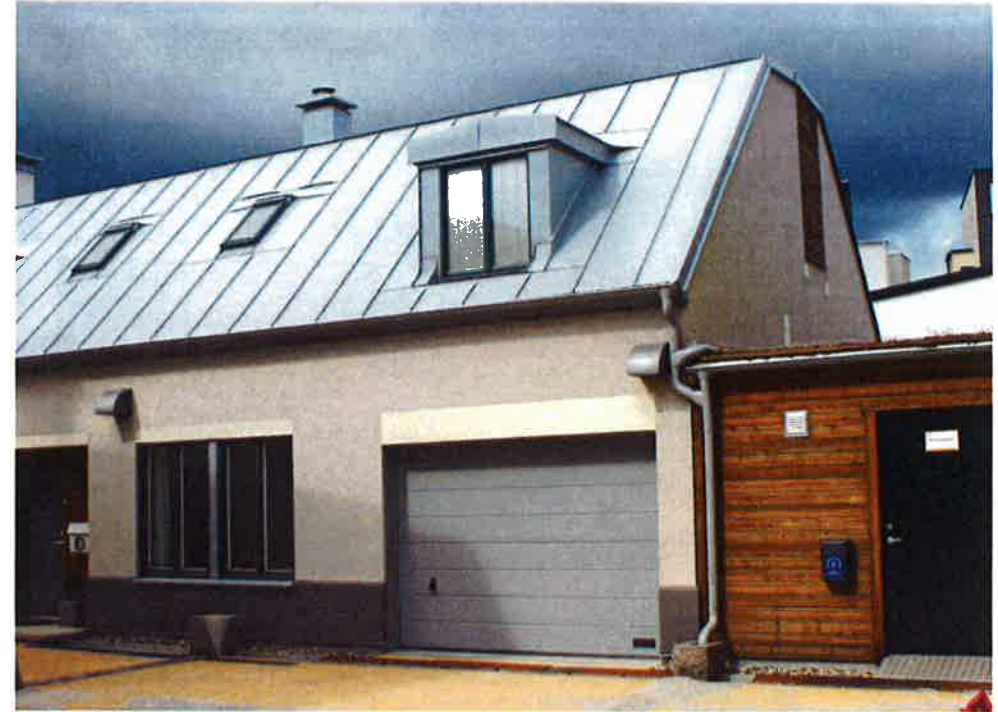
KUVA 15. Esimerkki räystään vähäeleisestä toteutuksesta.
